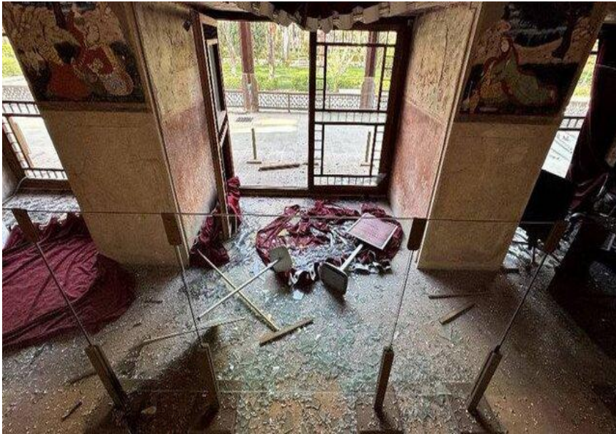
شکل ۲۸ تخریب مجموعه چهار ستون اصفهان (ایسنا، ۱۴۰۵)
