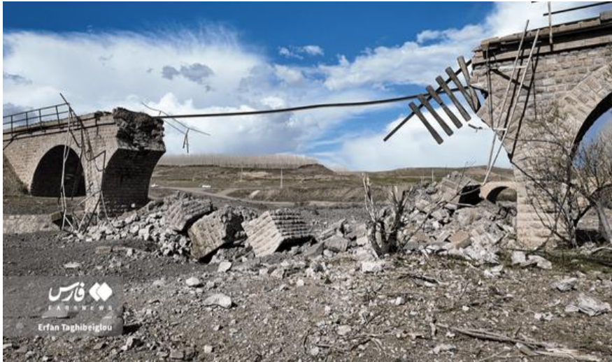
شکل ۱۶ تخریب پل راه آهن قم (خبرگزاری فارس، ۱۴۰۵)
