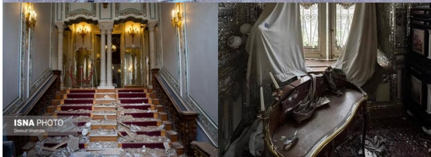
شکل ۳۰ تخریب مجموعهٔ سعدآباد تهران (ایسنا، ۱۴۰۵)
