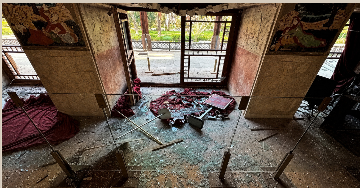
شکل ۳۴. تخریب مجموعه چهلستون در اصفهان.
