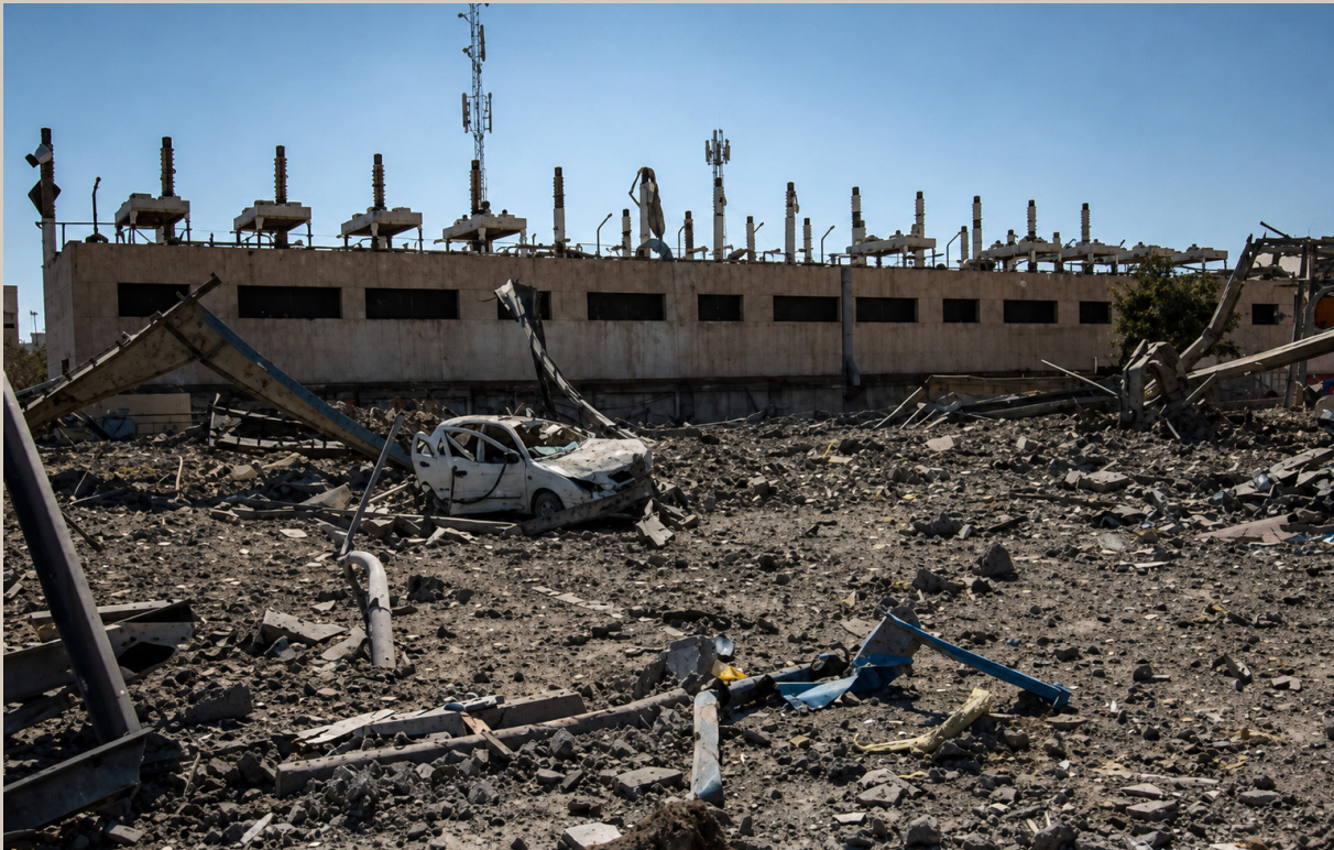
شکل ۲۸. تخریب ورزشگاه بعثت در تهران
