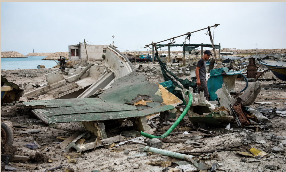
شکل ۱۰. آسیب به اسکله صیادی در شهر جاسک
