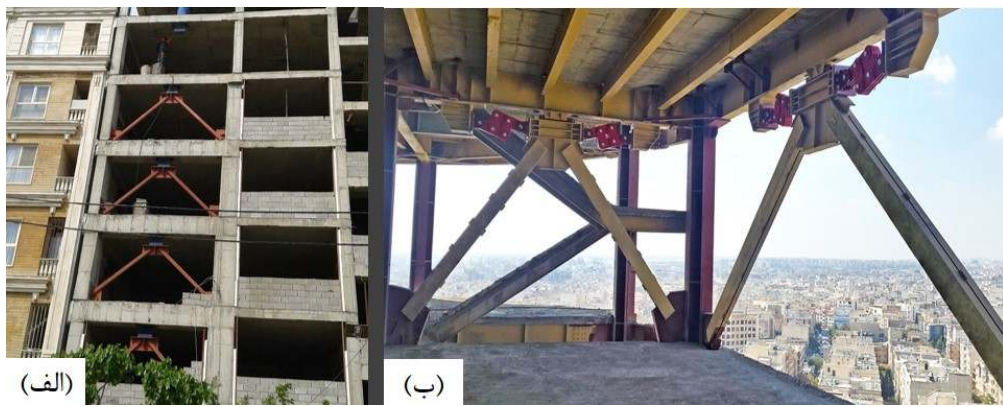
تصویر شماره‌ای ۳- (الف) میراگرهای تسلیم شوند در یک ساختمان مسکونی در تهران. (ب) میراگرهای اصطکاکی در مهدی کلینیک تهران
